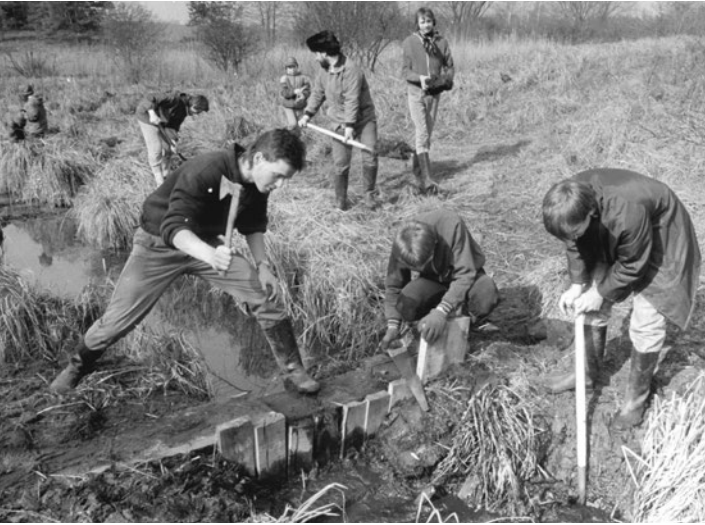
Booßen, Bau eines Schutzdamms für ein Biotop, 1988
